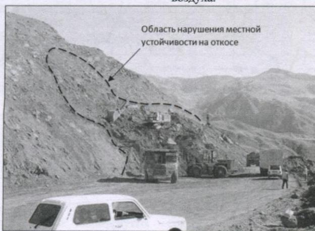
Рисунок 3. Нарушение местной устойчивости откоса после выпадение осадков
